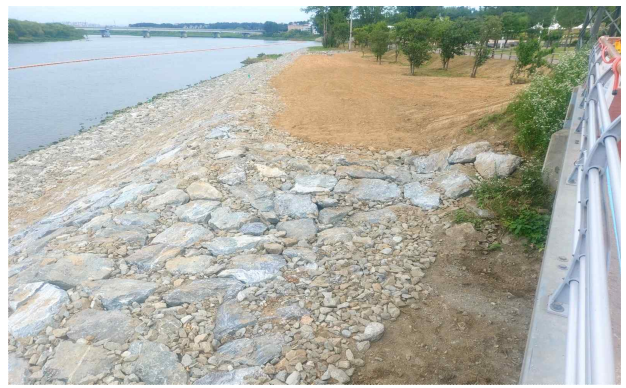
평택지구 저수호안 설치
