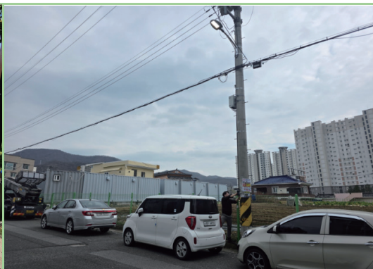
스마트 안전마을 보안등 설치공사
