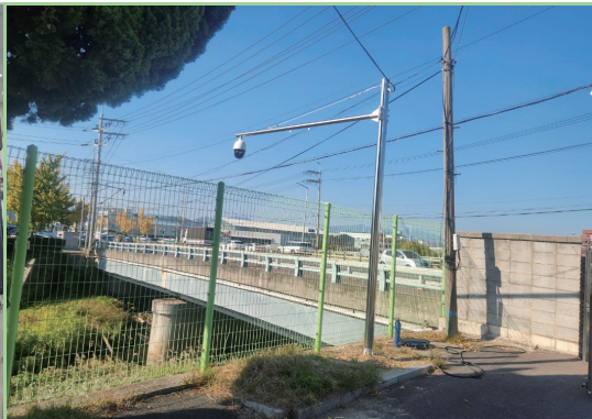
배수펌프장 자동화 운영용 CCTV 시스템 구축(준공사진)
