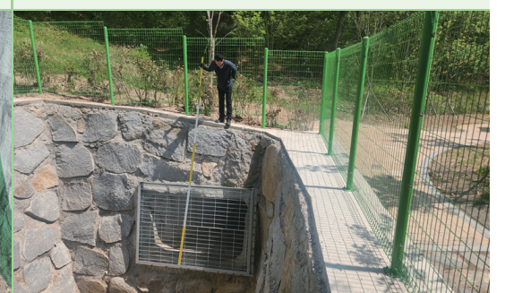
양정경로당 주변 상습침수 개선사업
