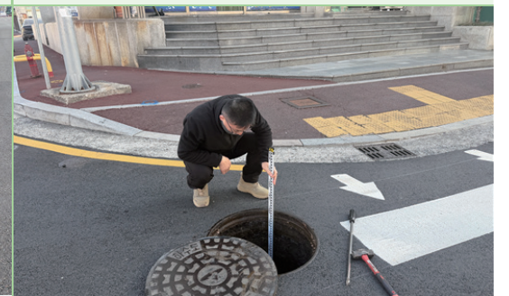
통샘1길 오수관로 확장공사
