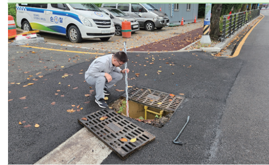
염포삼거리 일원 상습침수 개선사업
